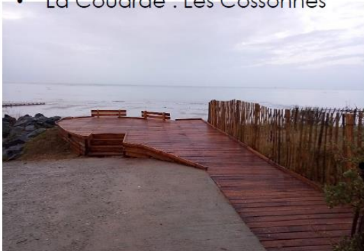
Aménagement d'une plateforme pour les personnes à mobilité réduite à La Pergolas
