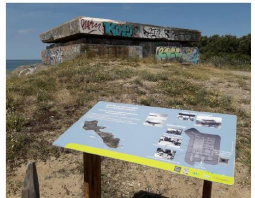
Aménagement de la batterie Herta
